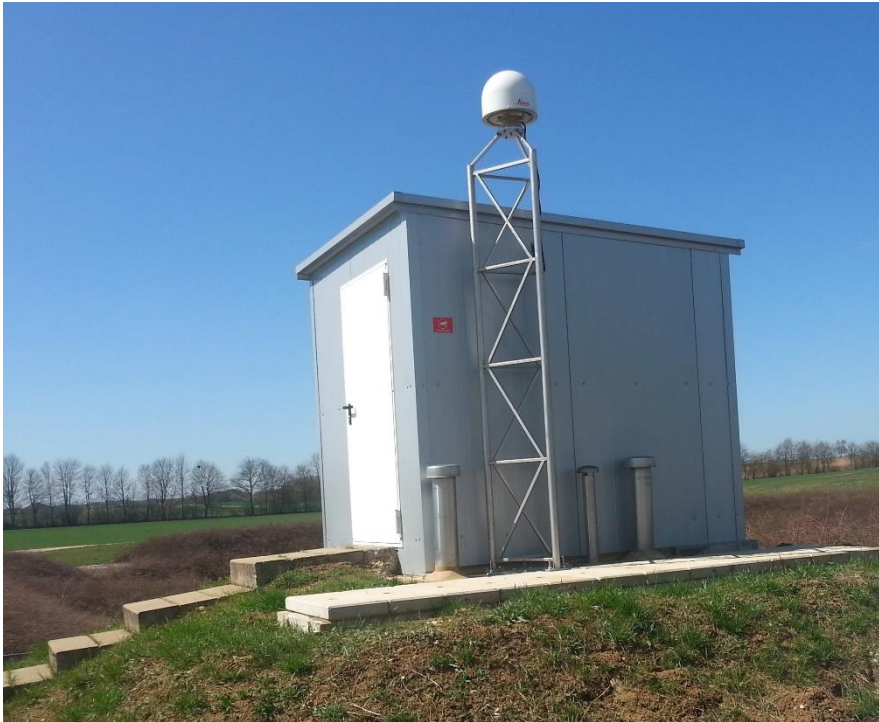
Abb. 1: SAPOS-Referenzantenne, bei Eichstätt
